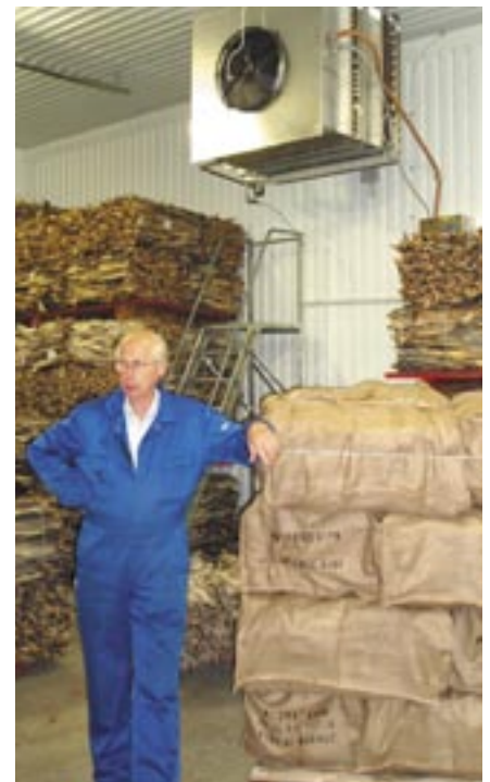
Bjarne Notø, ved Notø A/S, fikk installert klimastyring på sitt tørrfisklager i forbindelse med prosjektet "Kjenn eget lager".
