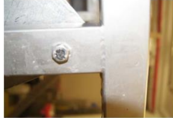
9.6 tette overmalte sveisekjøter
