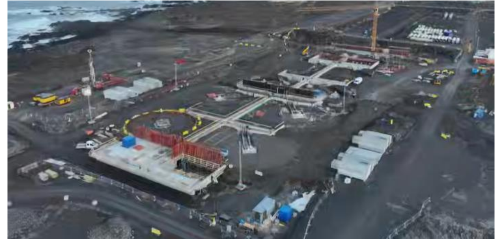
«Salmon Garden» under construction
