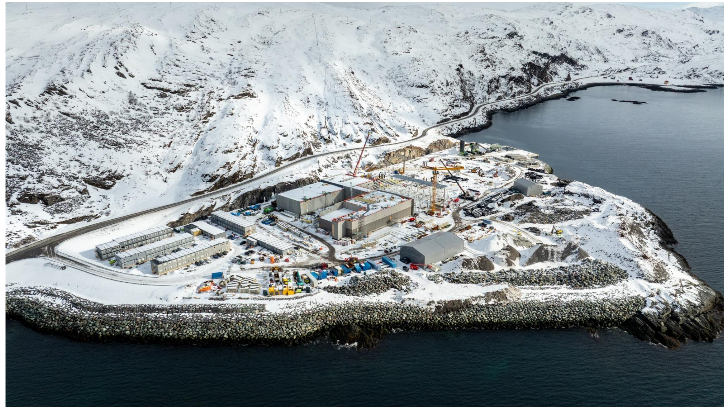
Cermaq Norway Veines, Sørøya, mars 2025. 3200 tonn/år postsmolt RAS, 22000 m 2 grunnflate. Foto: Cermaq Norway
